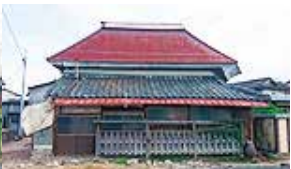
図-4 解体後旧荒木家住宅
