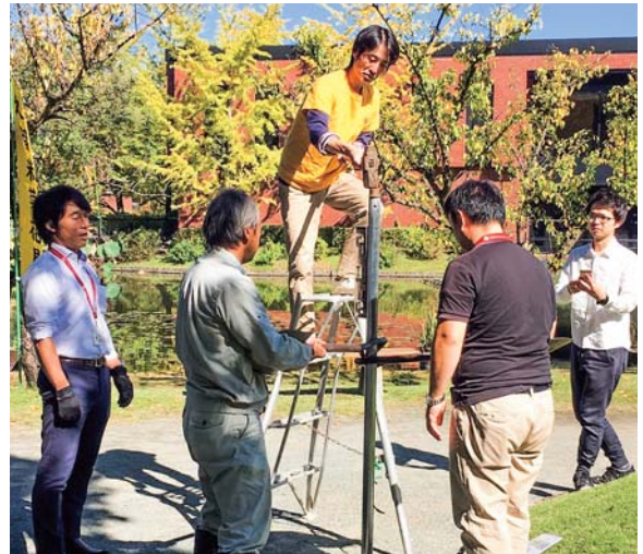
図12：単管パイプ設置の様子
