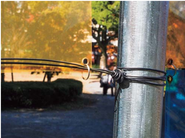
図13：バインド線によるシート固定箇所
