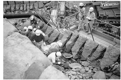
写真-22 仙台城・石垣の裏側（石材の控え）
