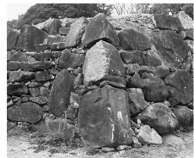
写真-20 名護屋城の縦積み
