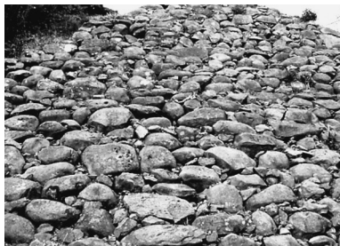
写真-16 野面石の布積み・1570年代～
