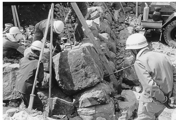
写真-24 経験豊富な石工棟梁による「旧状に復するための確認作業」
