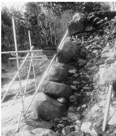
写真-21 名護屋城の裏込め状況
