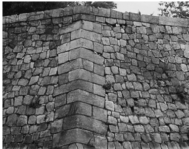
写真-17 規格石の布積み・1620年代～
