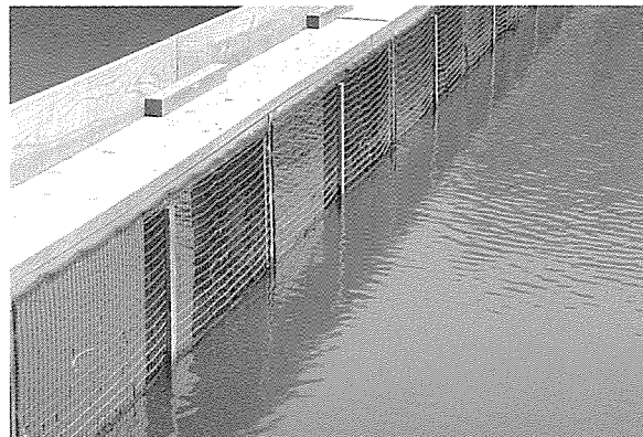
写真9. 隔離用のナイロン網と越入防止の天板
