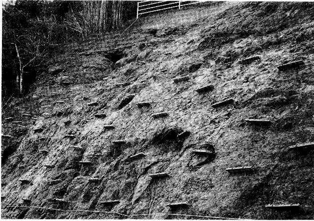
写真-2 発泡廃ガラスボードの設置状況
