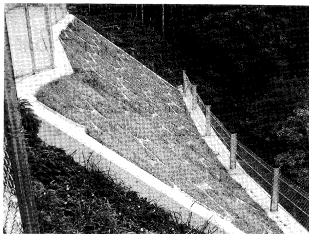
写真—4 施工後約2年の緑化状態
