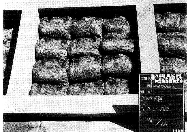
写真-3 発泡廃ガラス材を混入した土のうを法枠内に布設した状態
