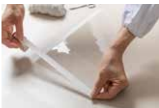
Fig. 24.3 Մաքրում ենք շրջակա ջուրը և թաղանթ կողմերից ամրացնում ենք թղթե կաշուն ժապավենով
