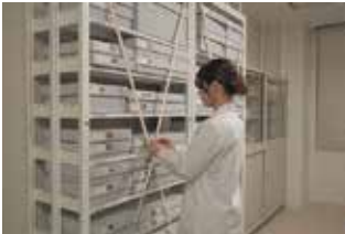
Fig. 11.2 資料の収蔵棚は耐震対策として固定し、安全ベルトを掛ける
