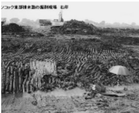
写真 1 バンコック東部排水路の掘削現場
