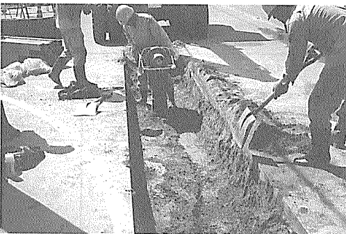
写真－５ ランマーによる締固め状況
