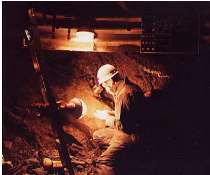
図1. 1 集水井内ですべり面を確認する作業風景
